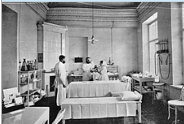
Рисунок 6. Фотография перевязочной (операци- онной) [2] Figure 6. Photograph of the dressing room (operating theatre) [2]
